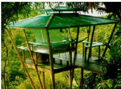
Dieses Gebäude in Puerto Rico nennt der Besitzer "Hooch". Auf einem existierendem Beton-Sockel mit einem Klär-Tank ist eine Bambuskonstruktion aufgeständert, die dem Besitzer als Schlafzimmer dient. Sonnenkollektoren auf dem Dach erzeugen den Strom einen Ventilator und Leselicht.
