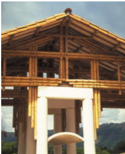
Oftmals ist Bambus nur auf Druck belastet worden. Seine Qualität liegt aber in der Fähigkeit, Zugspannungen aufzunehmen. Dies nutzt Vélez in seinen Fachwerkkonstruktionen, die bis zu 9 m auskragen und über 27 m spannen können.
