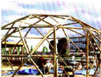
Es gibt mindestens zwei Projekte, in denen er Bambus als Tragstruktur verwendet hat. Zum einen entwarf er in Fukuoka/Japan geodätische Kuppeln aus Bambus ( 1989 ).
